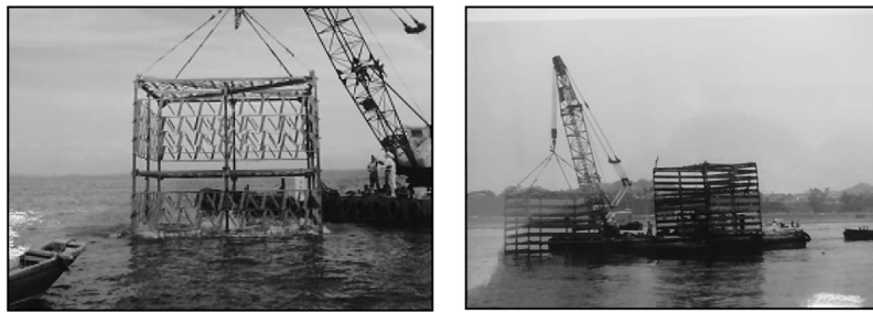
図4. 鋼製漁場の積み込み（左）と設置風景（左）.
