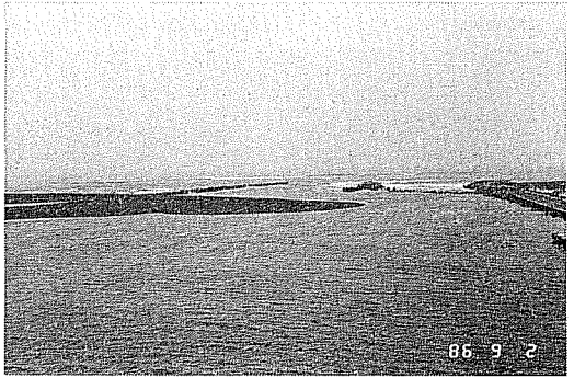
写真2 河口内で発達した砂州(昭和61年9月2日撮影)
